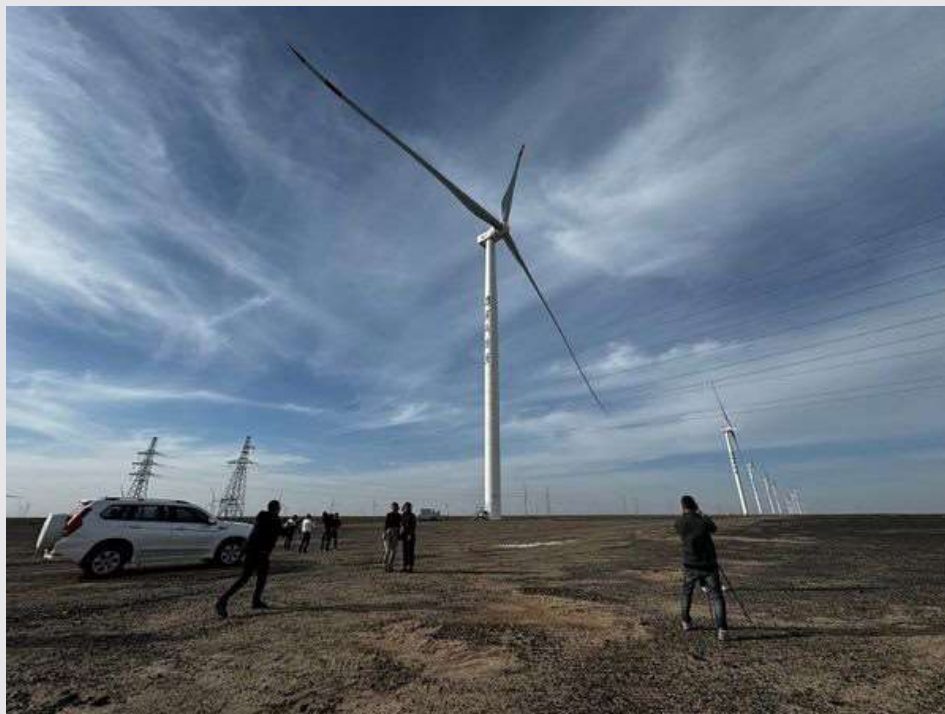
پروژه نیروگاه بادی بیداچیانو، گواژو، استان گانسو
